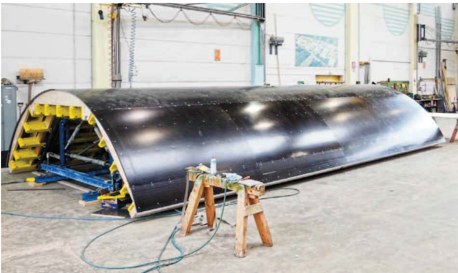
▲ Der Fertigservice der Doka-Niederlassung München montierte die Gewölbeelemente exakt vor und belegte sie mit DokaPly Birch Schalungsplatten.
